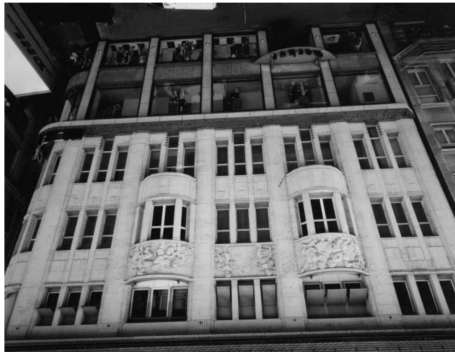
Foto einer Fassade in der Eisengasse für den Stadthimmel von Renate Buser. – Bild: Renate Buser
